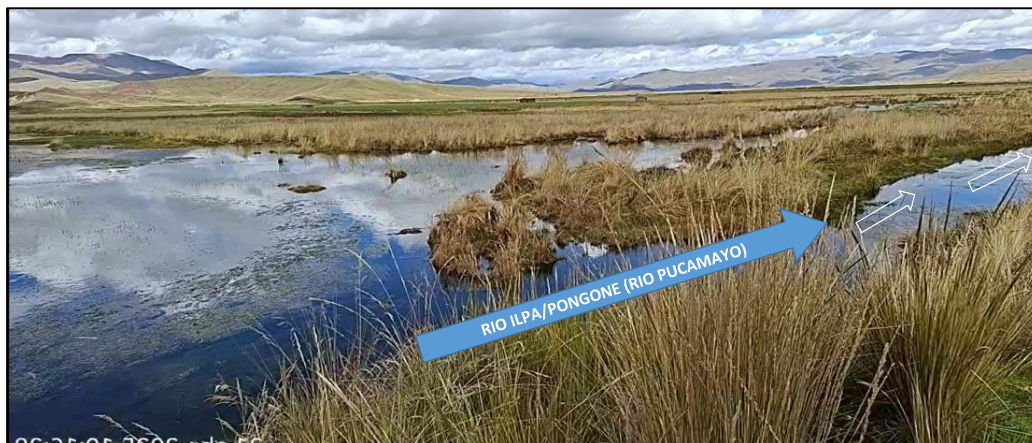
FIGURA 2: TRAMO CRÍTICO EN EL RIO ILPA/PONGONE (RIO PUCAMAYO), EN EL SECTOR TUNCUNI, DISTRITO DE CABANA, PROVINCIA DE LAMPA - PUNO. NOTESE, EL DESBORDE E INUNDACIÓN A CAUSA DE LA SEDIMENTACIÓN QUE REDUCE LA SECCIÓN HIDRAULICA DEL CAUCE DEL RIO.
